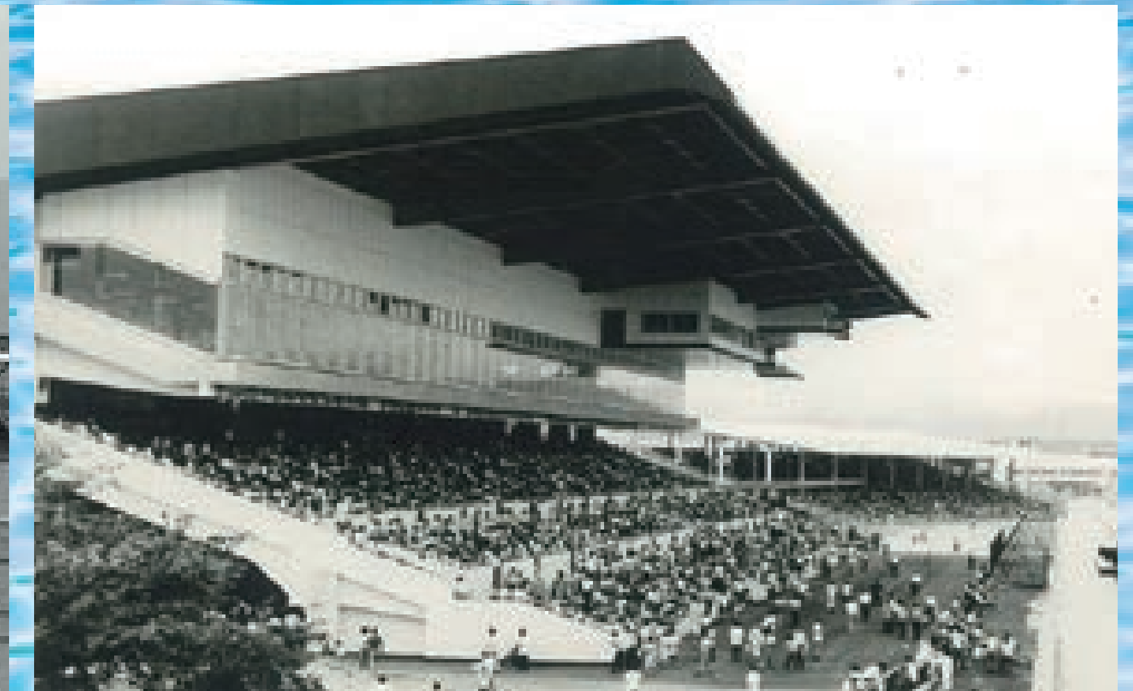
■メインスタンド1期工事完成
