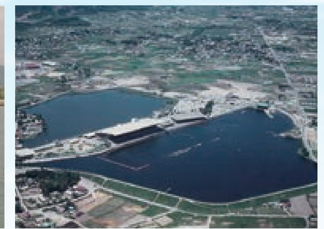
■緩衝器つき消波装置、バックストレッチ側、全長426mを設置して競走水面がプール化された
