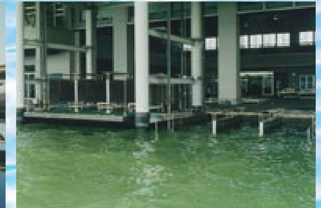
■ボートリフター新設
