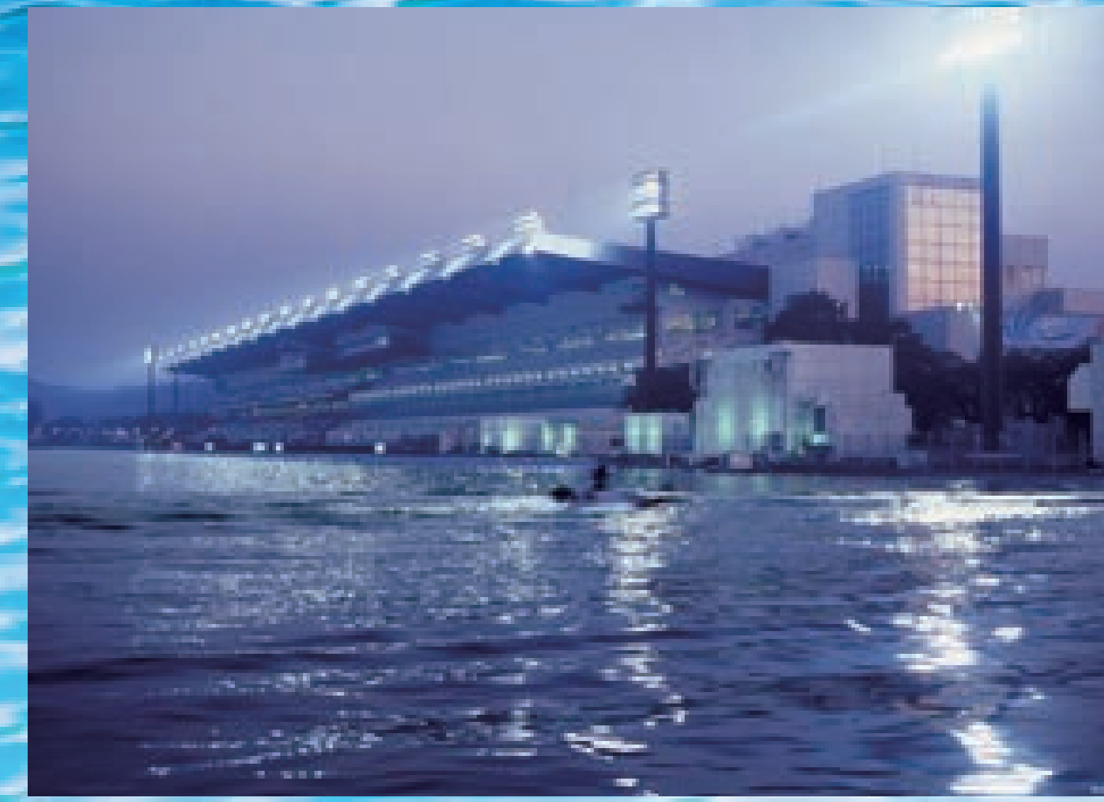
■ナイター照明設備
